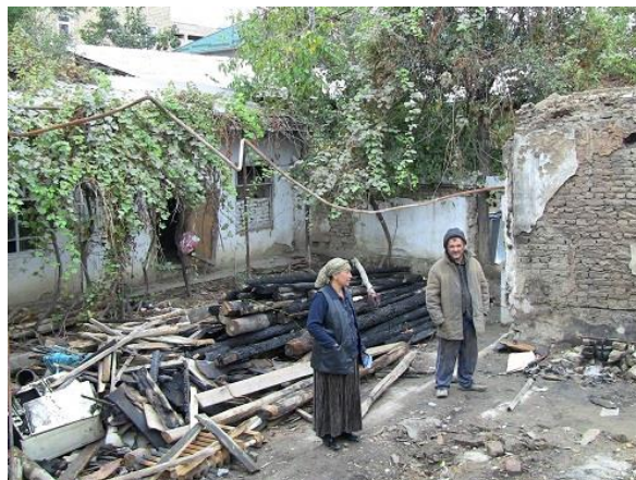
Разрушенный дом Нафисы. Фото: Жаныл Жусупжан
